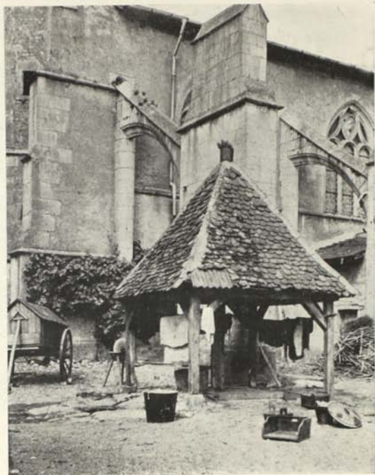
Puits de Varangeville.
