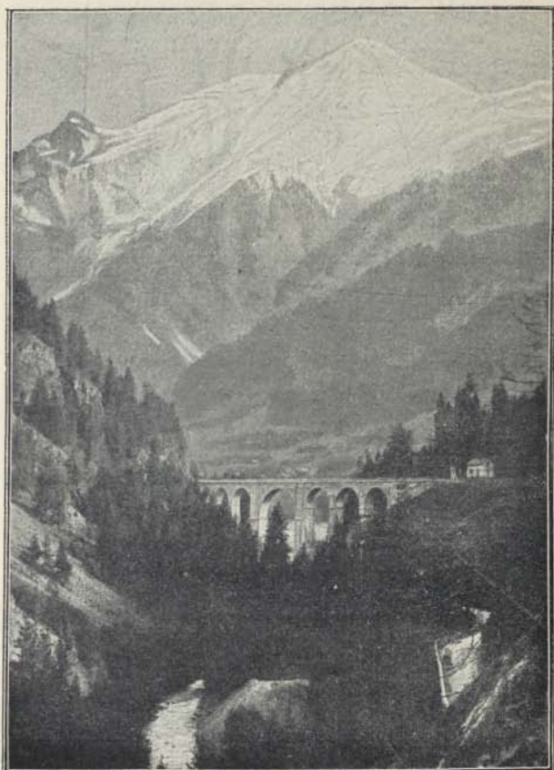
Vue du viaduc de Sainte-Marie.
